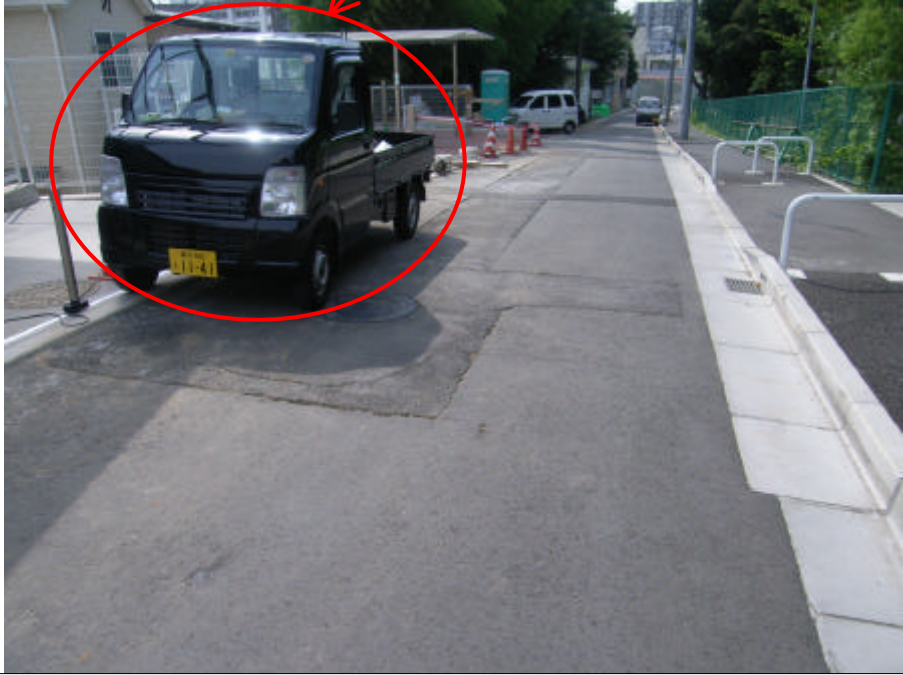
箕輪町舗装工事
