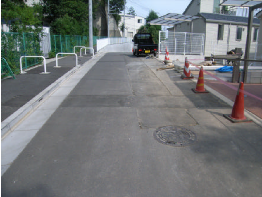
箕輪町舗装工事
