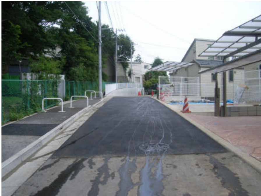
箕輪町舗装工事
