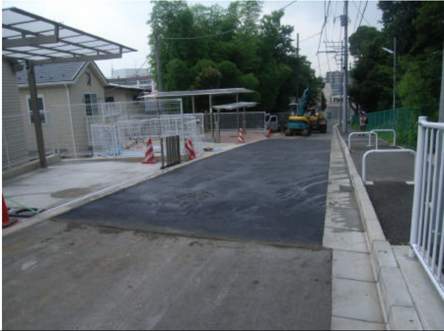
箕輪町舗装工事
